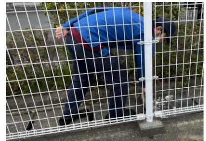
③ 流出防止板を挿入する
