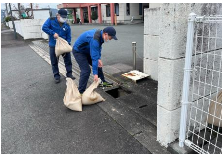
④ 土嚢投入
